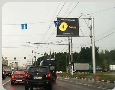
Металлоконструкции для 118 информационных светодиодных экранов (ТОИ) в г. Москва в рамках создания «Автоматизированной системы информирования участников дорожного движения»
